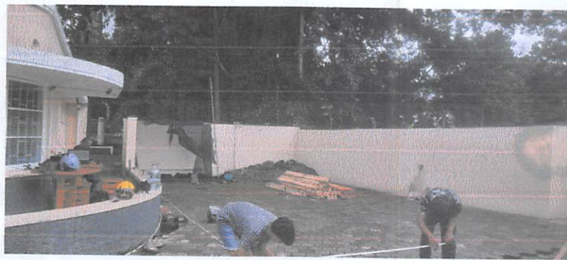
Pekerjaan pemasangan Bouwplank
